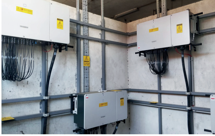
SG110CX inverterler 9 adet MPPT'ye sahip olup toplamda 18 adet dize girişini destekler.
